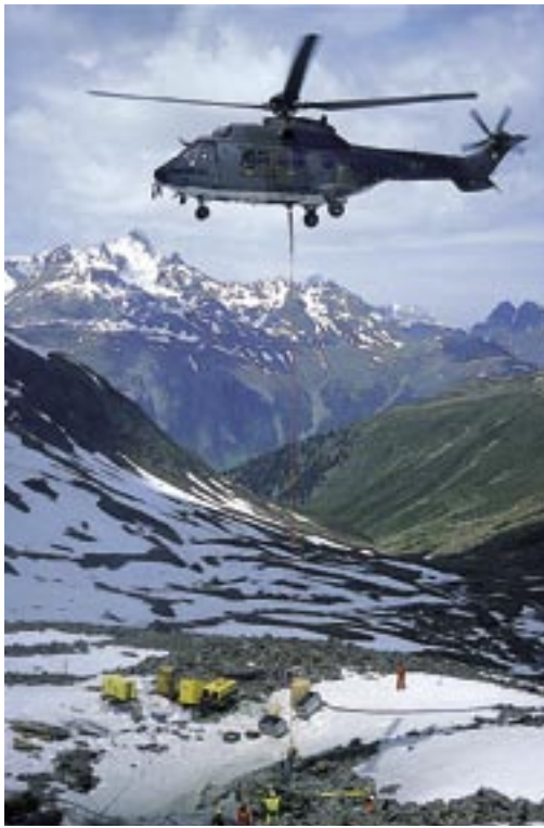
Bohrungen im alpinen Permafrost sind nicht nur bohrtechnisch anspruchsvoll, sie erfordern auch eine sorgfältige Organisation und eine aufwändige Logistik.
