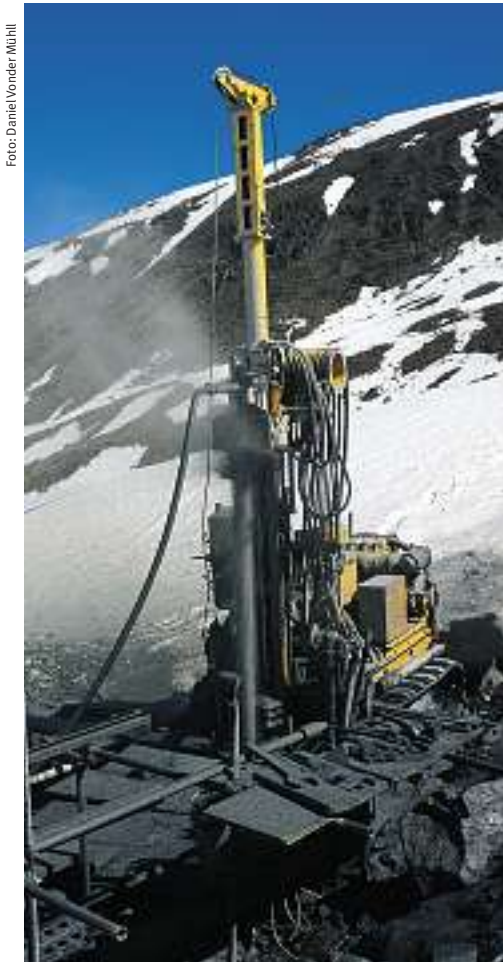
Damit der gefrorene Zustand erhalten bleibt, wird bei Bohrungen in eishaltigem Permafrost zur Kühlung kalte, getrocknete Luft eingesetzt.
